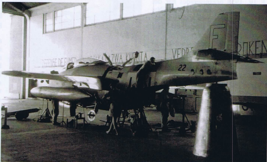
Motorservice på vit Filip. Konen bakom flygplanet utgör ubläsningskonen bakom turbinen. Foto SFF:s bildarkiv.
